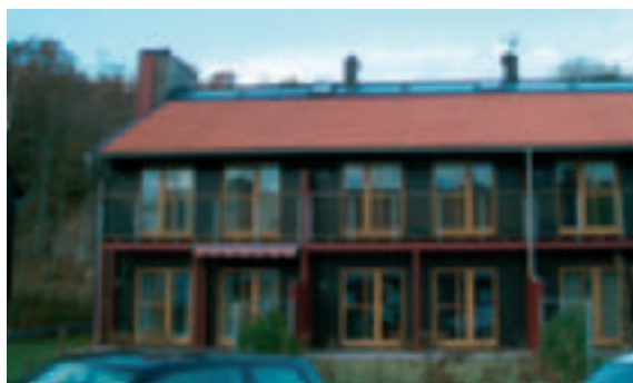
I "radhusen utan värmesystem" i Lindås utanför Göteborg svarar solfångarna, som mest liknar takfönster, för ungefär hälften av det årliga behovet av varmvatten. Foto: Tobias Boström.
