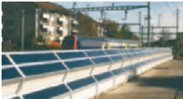
Solceller som bullerskydd vid järnväg.
