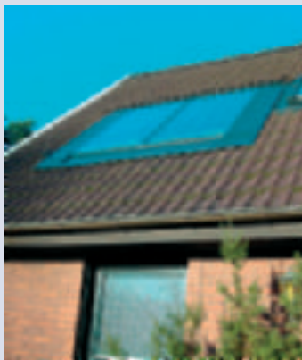
Denna takintegrerade solfångare levererade när bilden togs 50-gradigt vatten vid en utetemperatur strax under noll grader. Foto: Tomas Kåberger
